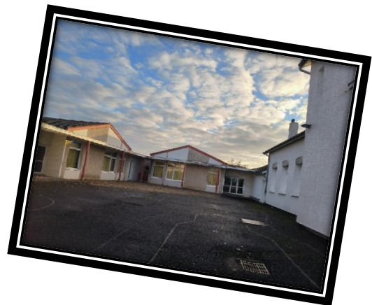
Projet Bâtiment à rénover
